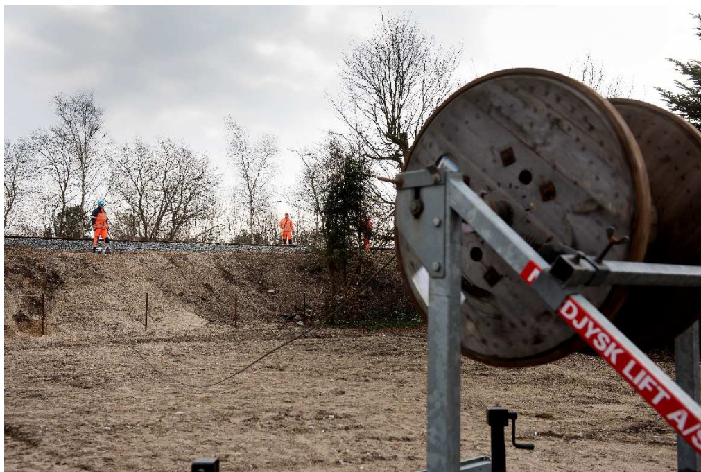
Arbejde ved sporstrækning i forbindelse med Signalprogrammet.
