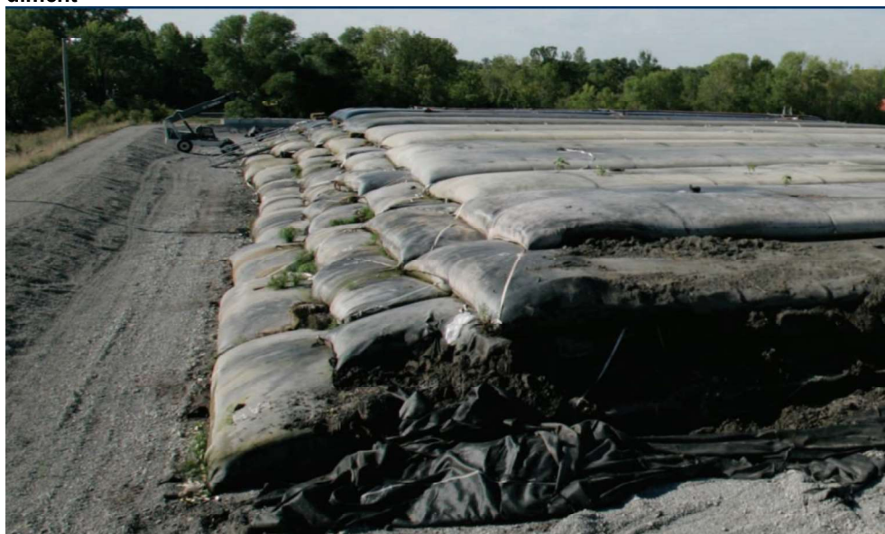
Figur 4-3 Eksempel på anvendelse af geotubes til afvanding og deponering af sediment 20
