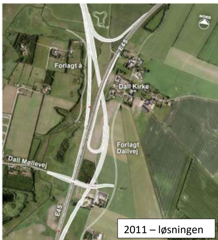
Figur 4.4 Forbindelsesanlæg ved Dall Kirke.
