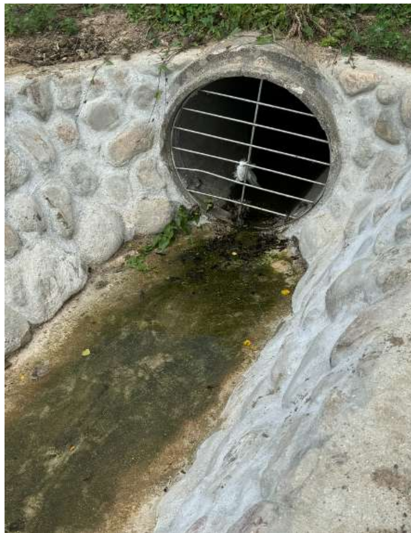
Udløb 2. MEGA UDLØB fra Lautrup park - kæmpe område med p-plads for mange tusinde biler. INGEN RENSNING. 850 m 3 /sek.
