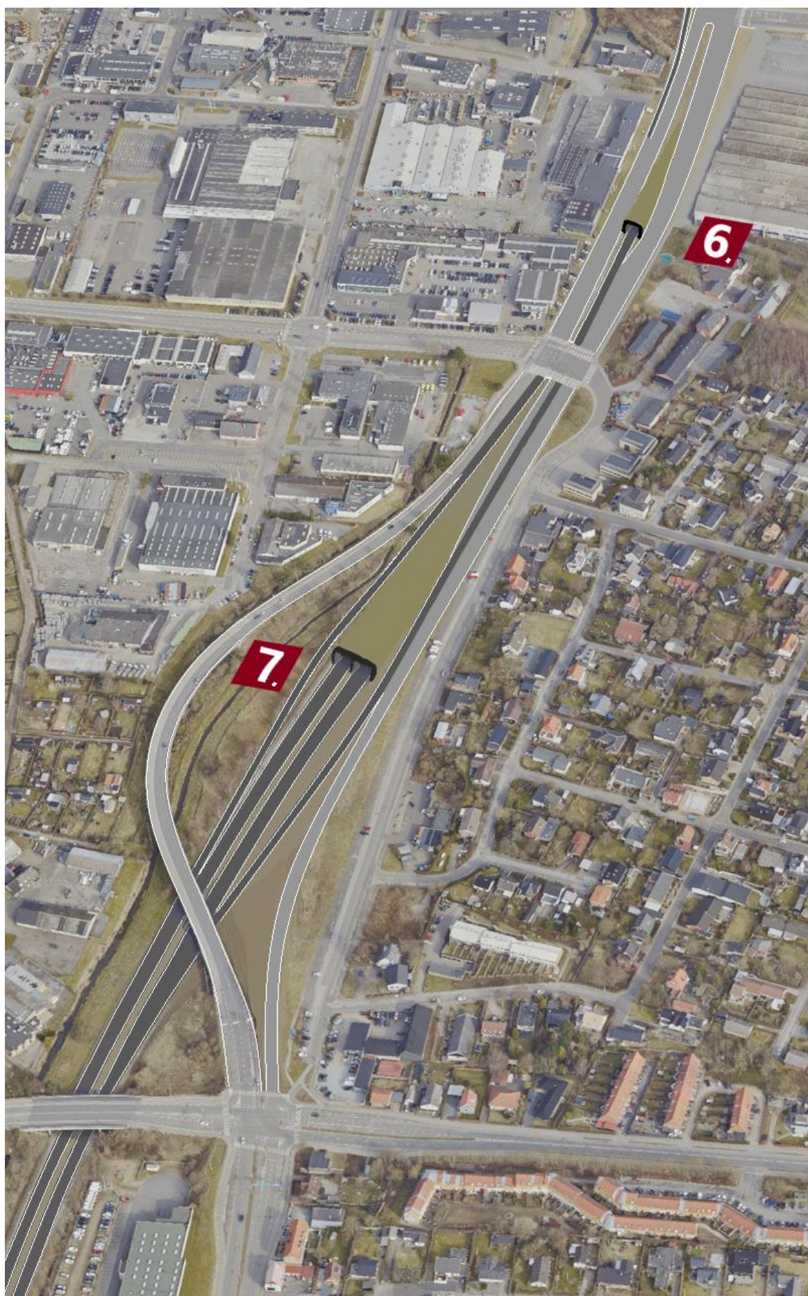
Skråfoto set mod nord med tilkørslen til Ådalstunnelen fra Sønderbro i den nordgående side (6.) Omlægning af Sønderbros kørebaner udfor Frydendal og Eternitten. Den primære sydlige tunnelmunding af Ådalstunnelen, hvor den fortsætter i den eksisterende Ådalsmotorvej (7.) Her omlægges de eksisterende spor, der fører Ådalsmotorvejen og Sønderbro sammen.
