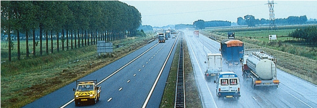
Figur 25 Drænasfalt (venstre side) på hollandsk motorvej en regnvejrsdag, kilde: VBW-Asfalt - Creative Commons Attribution-Share Alike 3.0 Unported license
