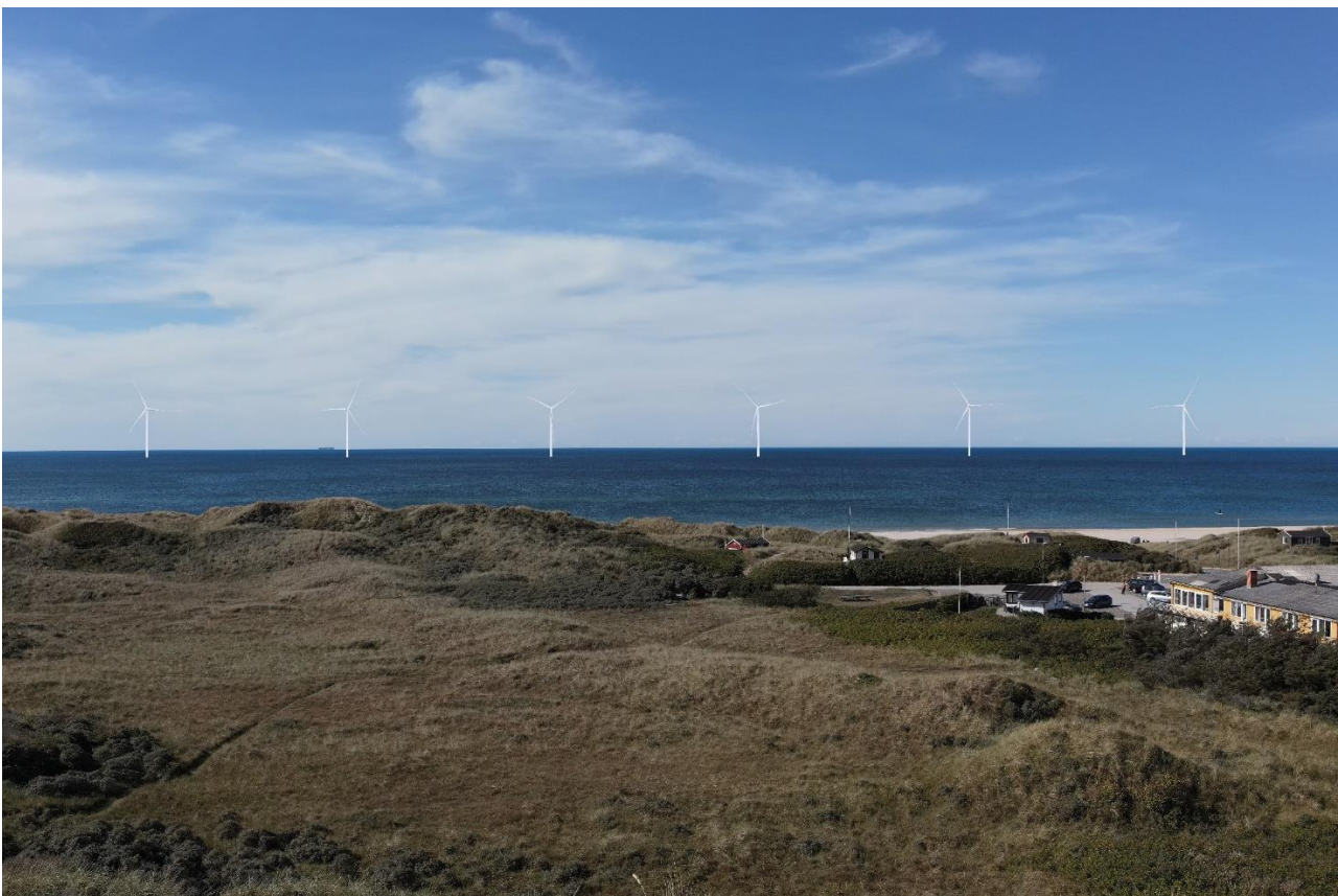
Kysten set fra "Kanonudsigten" ved Tornby Strand 26 meter over havet (Matr.nr. 159 Sdr. Tornby By, Tornby). Vindmøllerne er 300m i tiphøjde, 175m i navhøjde og 250 m i rotordiameter. Der er en afstand på 750 m mellem vindmøllerne. Afstand til møllerne fra Kanonudsigten er 4,8 – 5,3 km. Visualisering: BY+LAND
