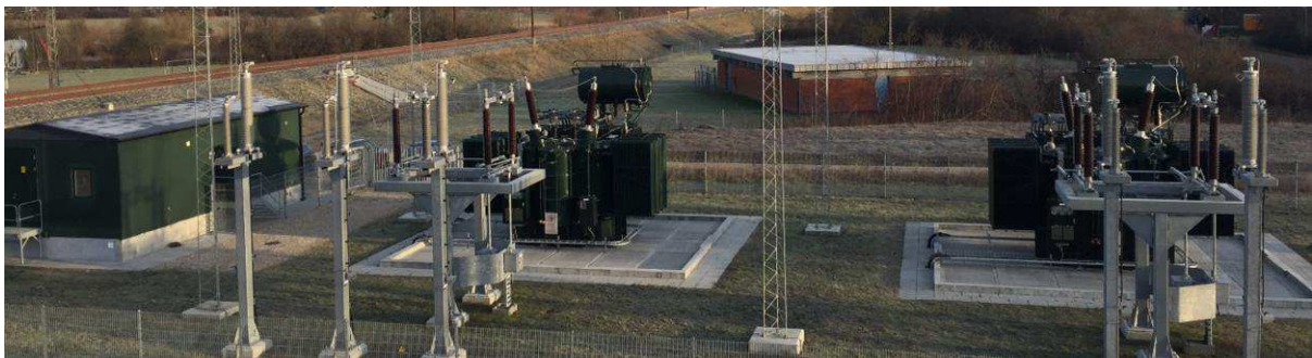
Figur 4 – Kildebrønne transformerstation [2 x 60 MVA]. Ny bane København-Ringsted
