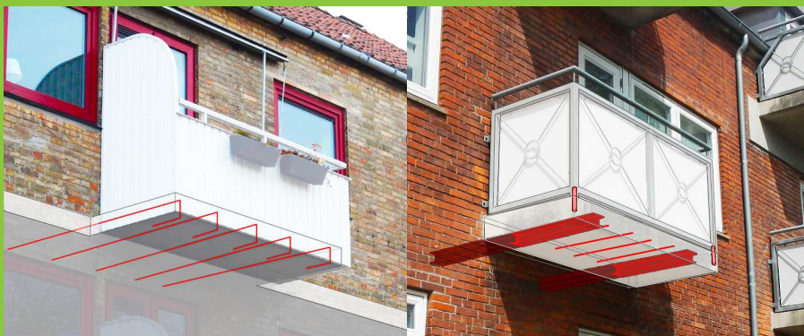
Figur 1: Den primære bærende funktion i en udkraget altanplade kan både være udført af indstøbte armeringsjern, som er med ud i altanpladen fra etagedækket (tv.) eller af omstøbte stålprofiler (udliggerjern), der er fastgjort til bjælkelaget (th.).
