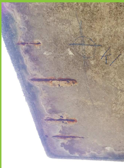
Figur 5: Venstre: Underside af altan med revne/begyndende afskalning parallelt med den langsgående armering i forkant. Revnen er her opstået pga. korrosion på det langsgående armeringsjern i forkanten. Bemærk at der ikke observeres rustfarvede udfældninger i forbindelse med revnen. Højre: Underside af altan med afskalninger over tværgående armering ved forkant. Disse afskalninger er startet som revner og har siden udviklet sig til regulære dæklagsafskalninger.
