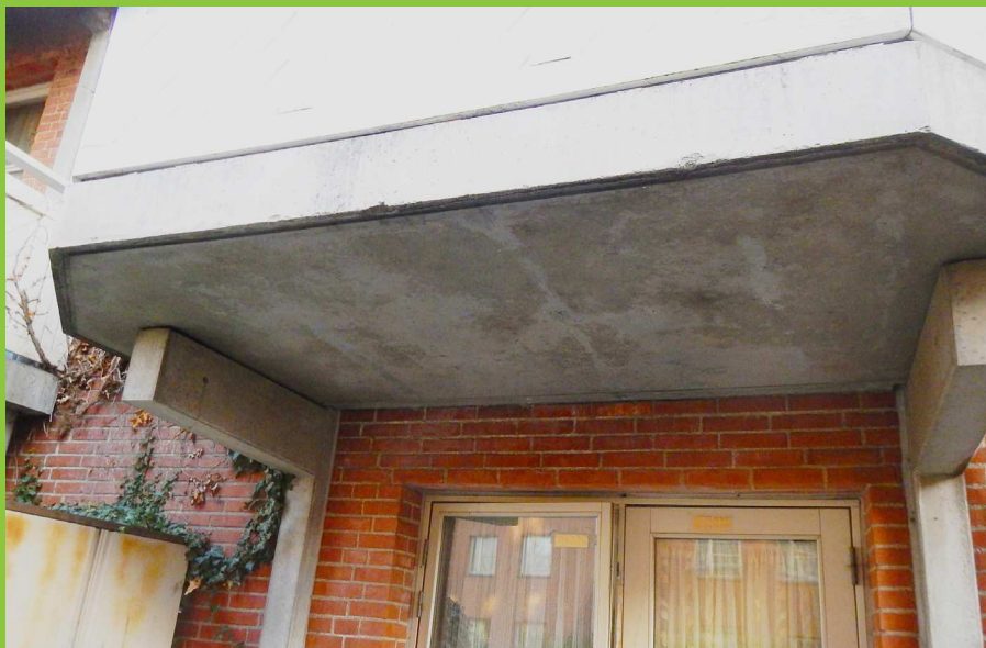
Figur 1: Eksempel på altan der er understøttet i altanens ender. I dette tilfælde er altanen understøttet af betonkonsoller, som bærer den overliggende altanplade. Den bærende armering ligger her i undersiden af altanpladen og er orienteret parallelt med facaden.
