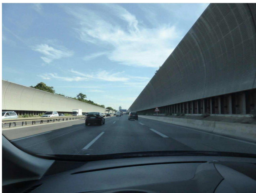
Højere støjskærme langs en motorvej i München
