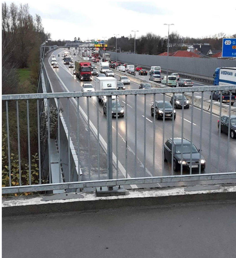
Nuværende støjskærme langs Motorring 3 i/ved Herlev Kommune
