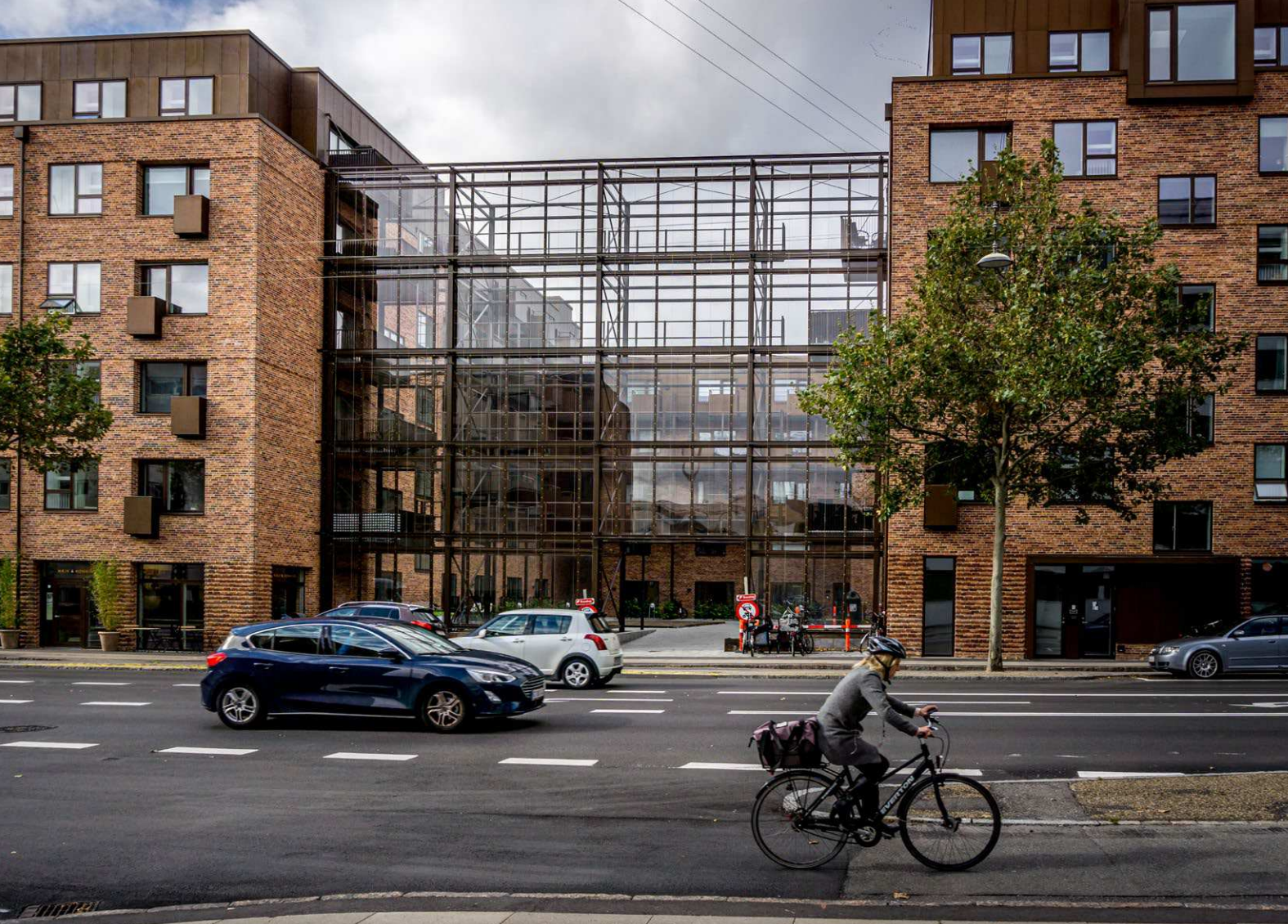
Ved Valby Maskinfabrik er der opført en høj glasskærm, som effektivt afskærmer bebyggelsens udendørs fællesarealer mod støj fra trafikken på Gl. Køge Landevej.
