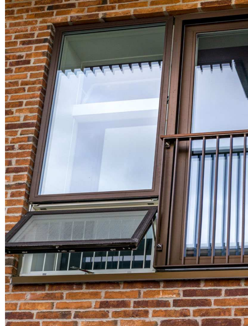
Ved ombygning af F.L. Smidths gamle fabrikshaller ved Gl. Køge Landevej til en ny bydel med boliger var der behov for at begrænse trafikstøj. Det blev løst med russervinduer i facaderne mod trafikken.
