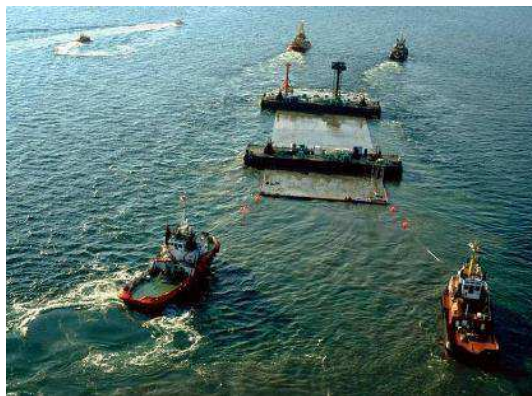
Figur 5-50 Eksempel på transport af sænketunnelement (Øresund)
