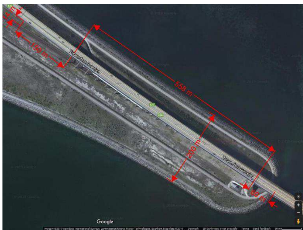
Figur 5-69 Udfletningsanlæg luftfoto (eksempel fra Øresund Peberholm)
