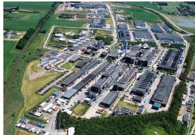
Novo Nordisk i Kalundborg kan levere varme til 1.350 husstande. Sparer 5000 tons CO2 årligt.
