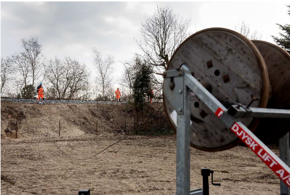
Arbejde ved sporstrækning i forbindelse med Signalprogrammet.
