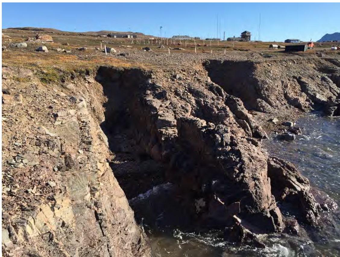
Foto 34. Delområde 2, foto taget mod syd. De gamle tankanlæg er fjernet og der er ingen synlig olieudsivning i skrænten.
