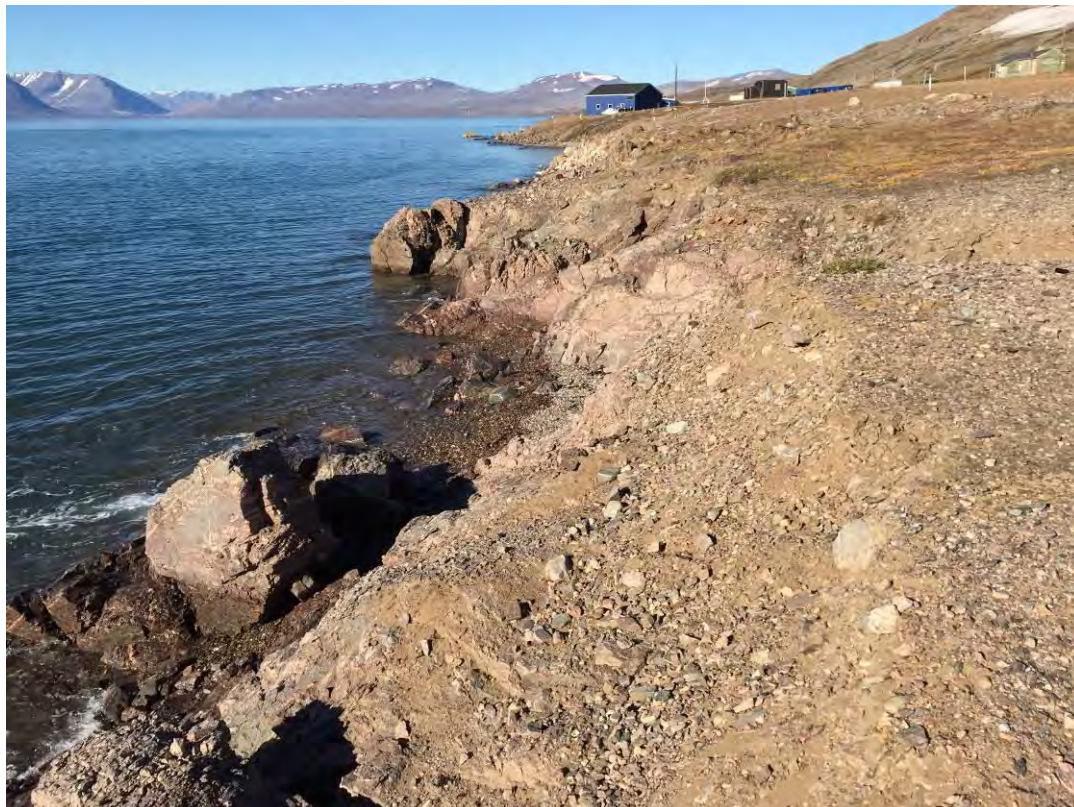
Foto 33. Delområde 1, foto taget mod nord. Gamle tankanlæg er fjernet og der er ingen synlig olieudsivning i skrænten.
