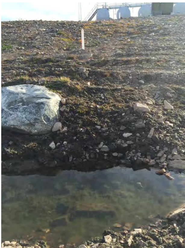
Foto 37. Delområde 7, foto mod øst. Det gamle tankanlæg er fjernet. Det nye ses i baggrunden. Der er ikke oliefilm i de afskærende render nedstrøms for kilden. Der er grøn algevækst i renderne.
