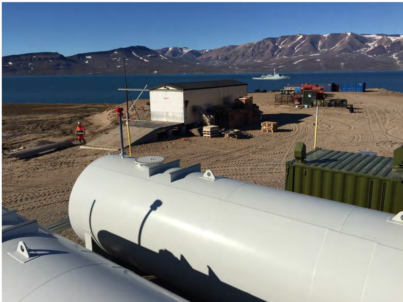
Foto 39. Knasten, delområde 8, foto mod vest taget fra toppen af det nye tankanlæg. Det gamle tankanlæg lå omtrent samme sted og har givet anledning til udsivning af olie til deltaet i venstre side af billedet.
