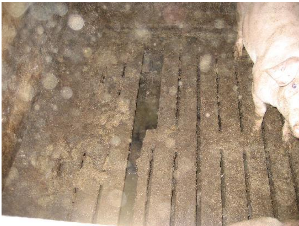
Foto 5.4: Defekt betonspaltegulv.
