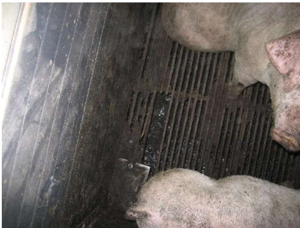
Foto 5.3: Defekt jernspaltegulv i farestald
