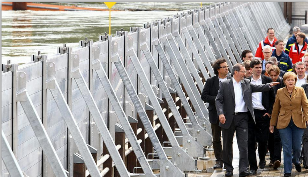
Sikringslinie langs Elben inspiceres af forbundskansleren – vandstand 3.50 m over normal, Barriere højden er 3,00 m og sikringskoten er på dette sted 4,80 m.
