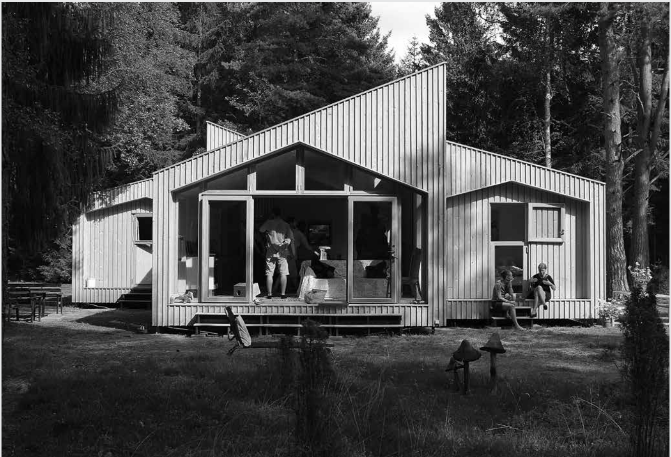
Sommerhuset i Asserbo er Danmarks første CNC-fræsedes hus, hvilket i princippet er et printet hus. Huset er tegnet på computer, og derefter er tegningerne blevet 'udskrevet' på en fræser i krydsfinerplader. Pladerne er nummereret og efterfølgende samlet. Huset er tegnet af arkitektvirksomheden EENTILEEN. Foto: Nikolaj Callisen Friis/CINARK
