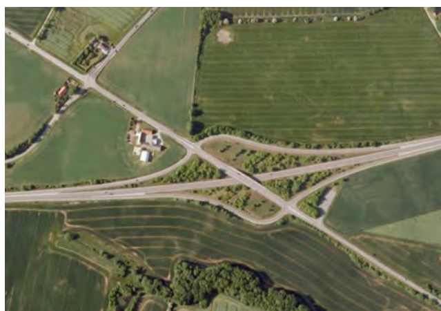
FIGUR 2.6 Tilslutningsanlæg ved Randersvej (TSA 16)
