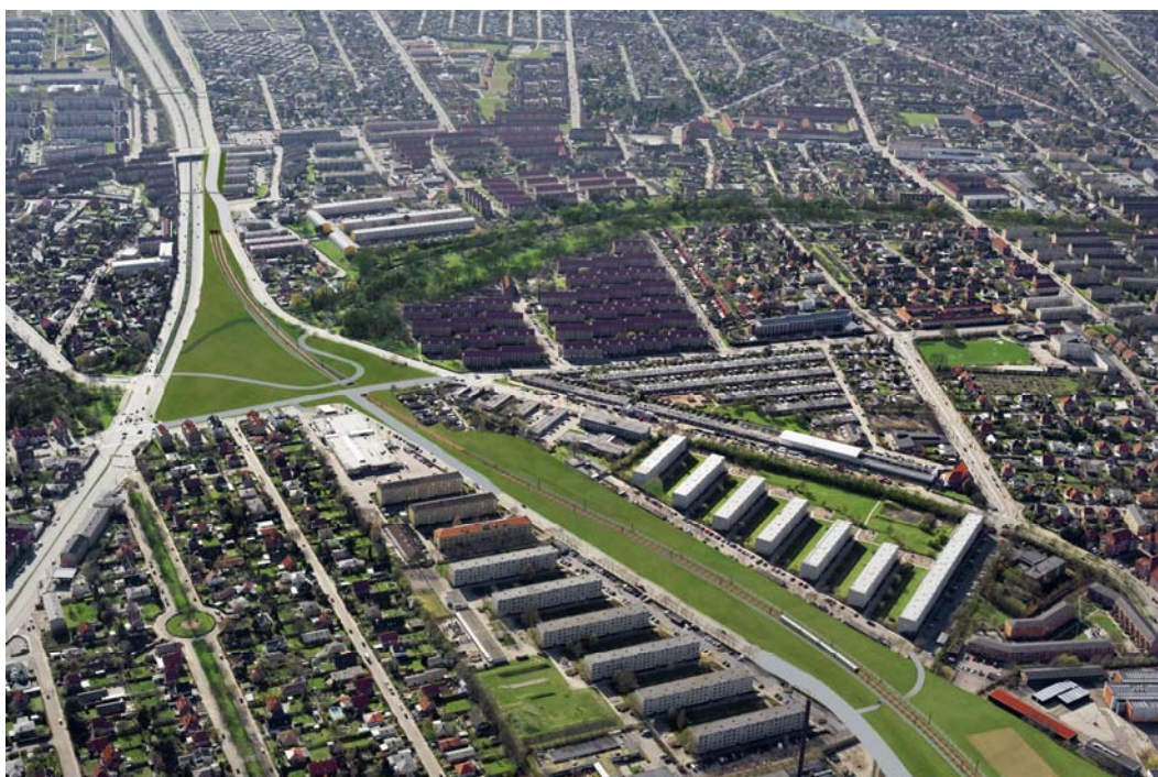
Løsningen med bane i åben afgravning ved Kulbanevej i Valby.
