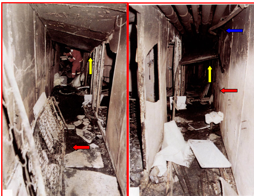
Figur 11. De två bilderna visar platsen för uppkomst av brand nr 3 (Hydraulbranden). På dessa bilder syns den säng (markerad med röd pil) som sannolikt har använts för att antända hydrauloljan. Blå pil markerar aktuellt hydraulrör, se även Figur 12. De övriga rören som är förlagda i samma taksektion som det läckande hydraulröret är ej synbart brandpåverkade. Notera att undertakskonstruktionen som innan branden täckte hela rörstråket är sönderbruten och hänger ned (markerat med gul pil) i korridorens längdriktning.
