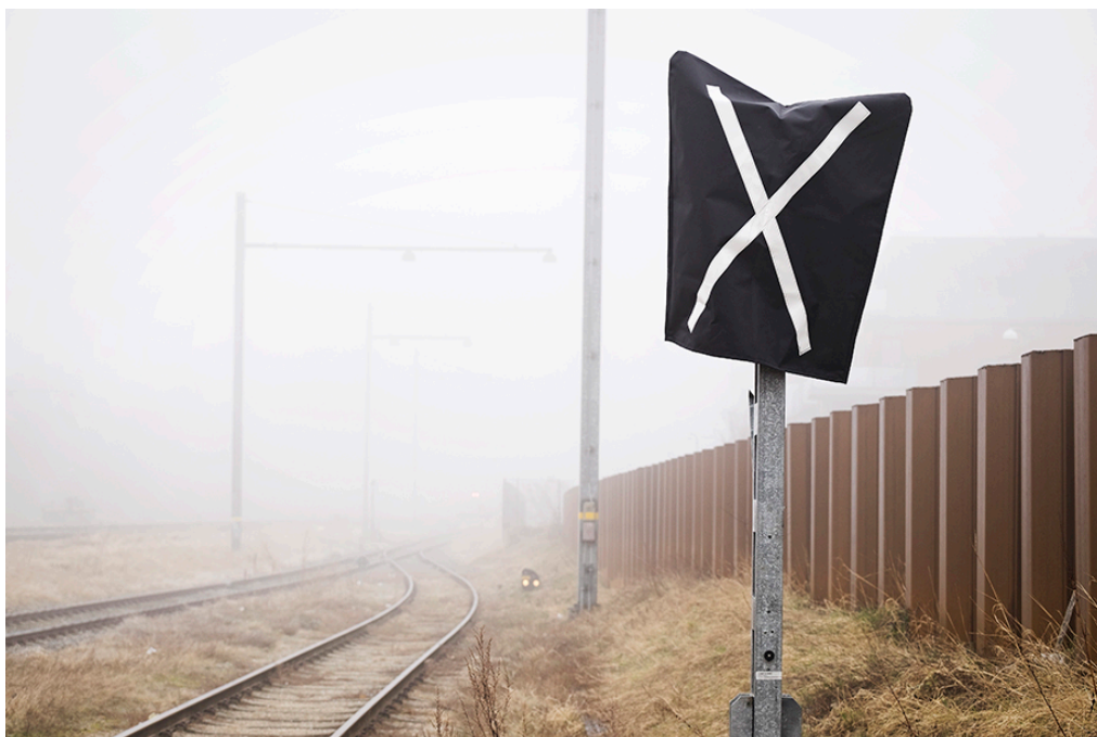
Gammelt signal, som er taget ud af drift ved udrulning af det nye signalsystem.
