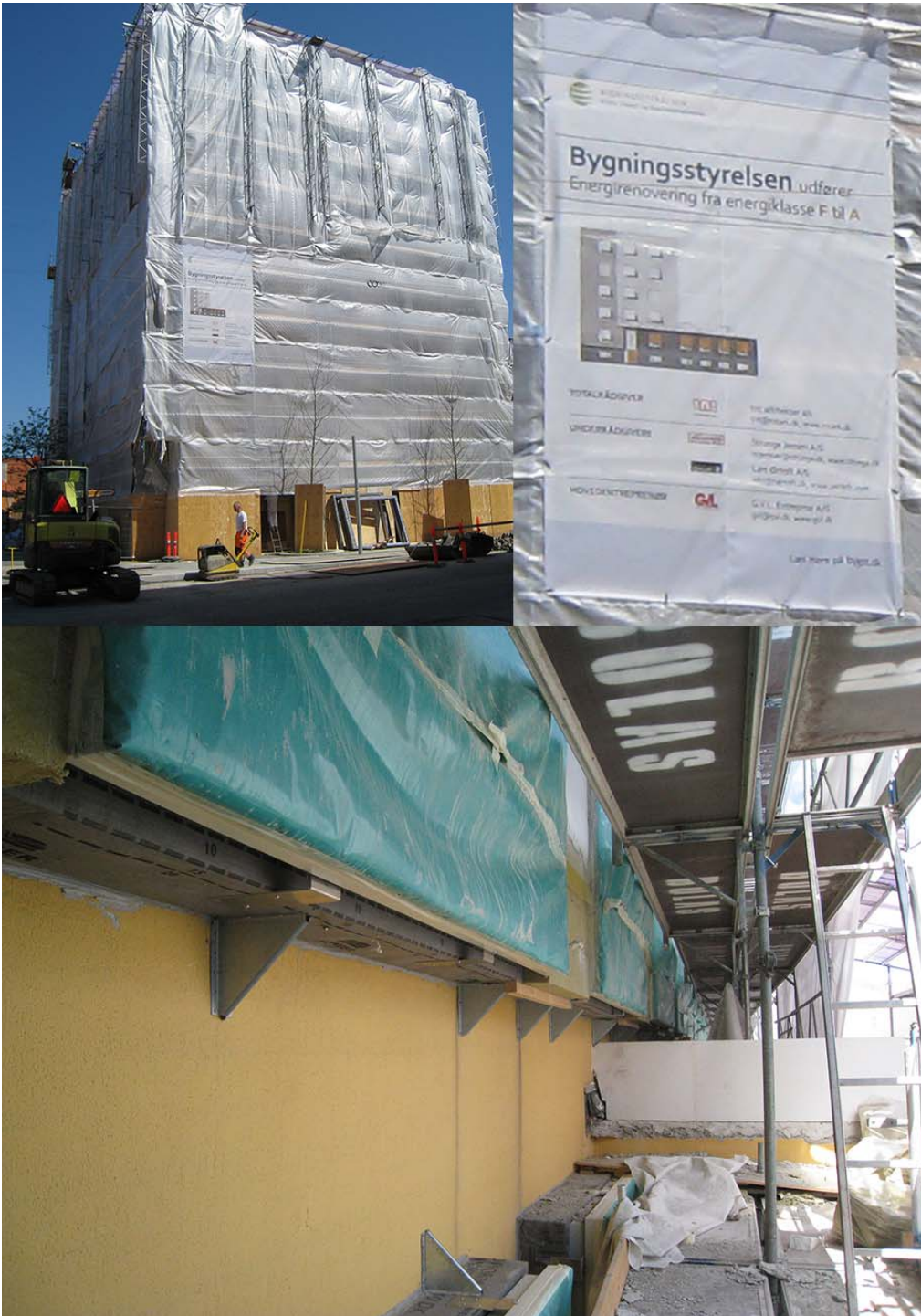
Energirenovering af Bygningstyrelsens kontorejendom fra 1938 i Vester Voldgade 123 i København. Via rentable energirenoveringer som fx efterisolering af facader rykkede styrelsen energimærket fra F til A og forventer, at energiforbruget bliver reduceret med 80 %.
