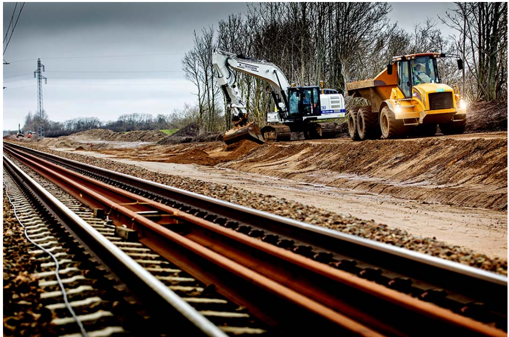
Sporlægning på strækningen mellem Vamdrup og Vojens.
