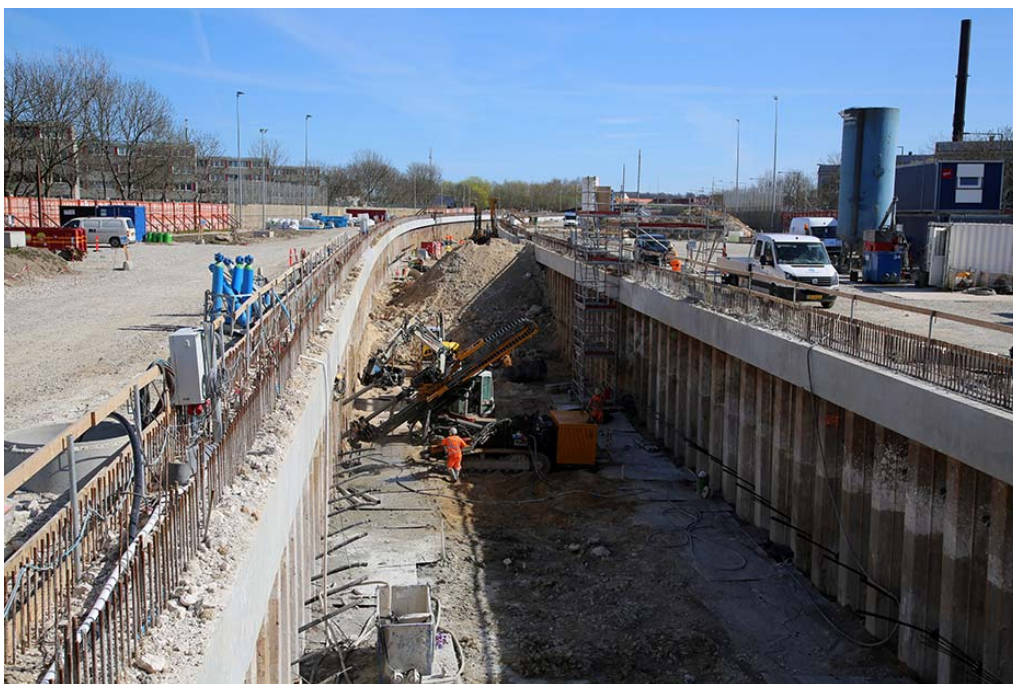
Konstruktion af trug til tunnel ved Kulbanevej i København.
