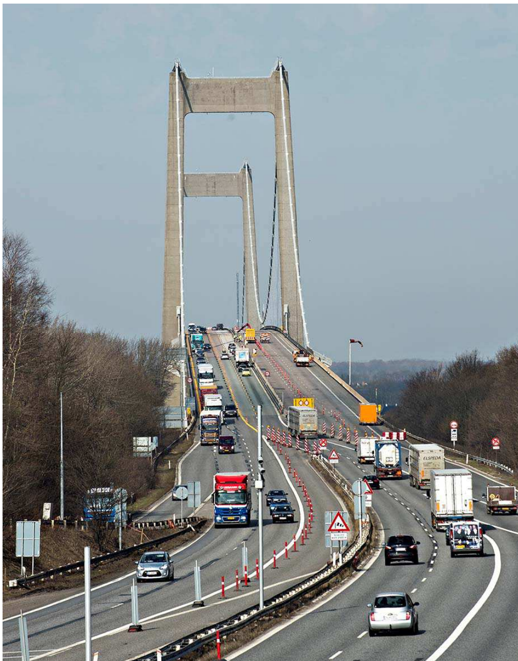
Vedligeholdelsesarbejde på Lillebæltsbroen.
