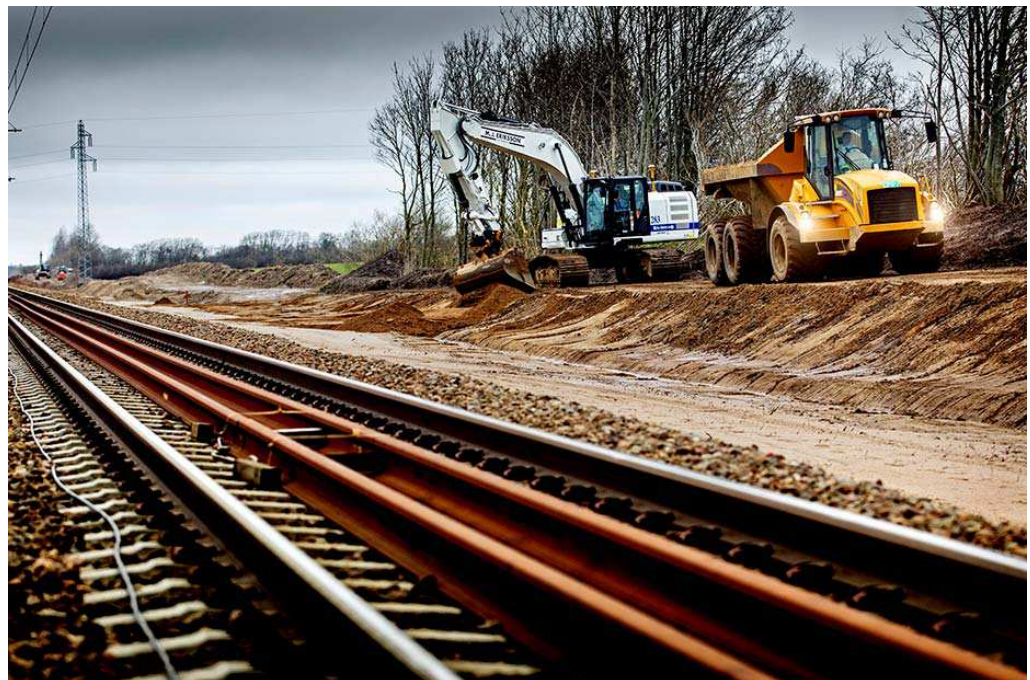
Sporlægning på strækningen mellem Vamdrup og Vojens.
