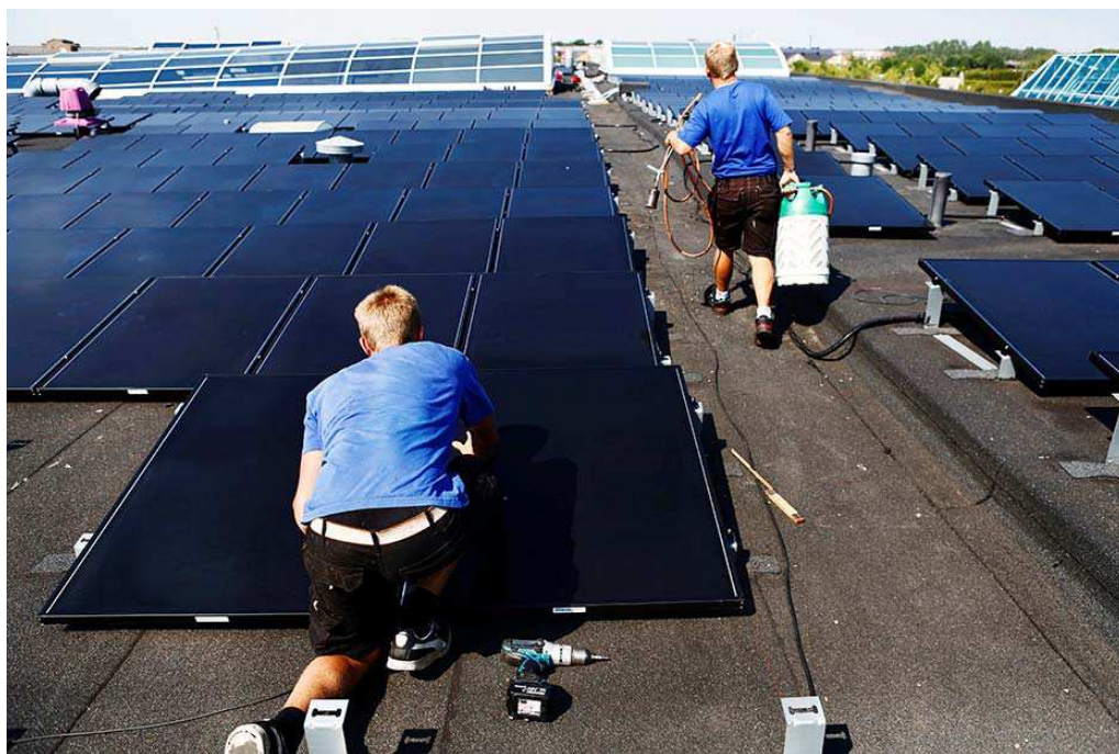
Håndværkere i gang med at montere et stort solcelleanlæg på taget af butikslokaler. Anlægget kan ikke opnå midlertidigt forhøjet støtte, men fordi butikker har et stort elforbrug i dagtimerne, hvor solcelleanlægget producerer mest, er det alligevel en god investering.
