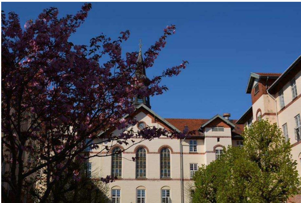
Forsorgshjemmet Sundholm rummer 5 boafsnit (etager) med hver sin opholdsstue, beboerkøkken og et antal toiletter/badeværelser. Boafsnittene rummer fra 4 til 14 enkeltværelser. Værelserne har en varierende størrelse fra 8 m 2 til 16 m 2 og er møbleret med seng, sengebord, bord, stol, klædeskab, kommode og hvilestol.
