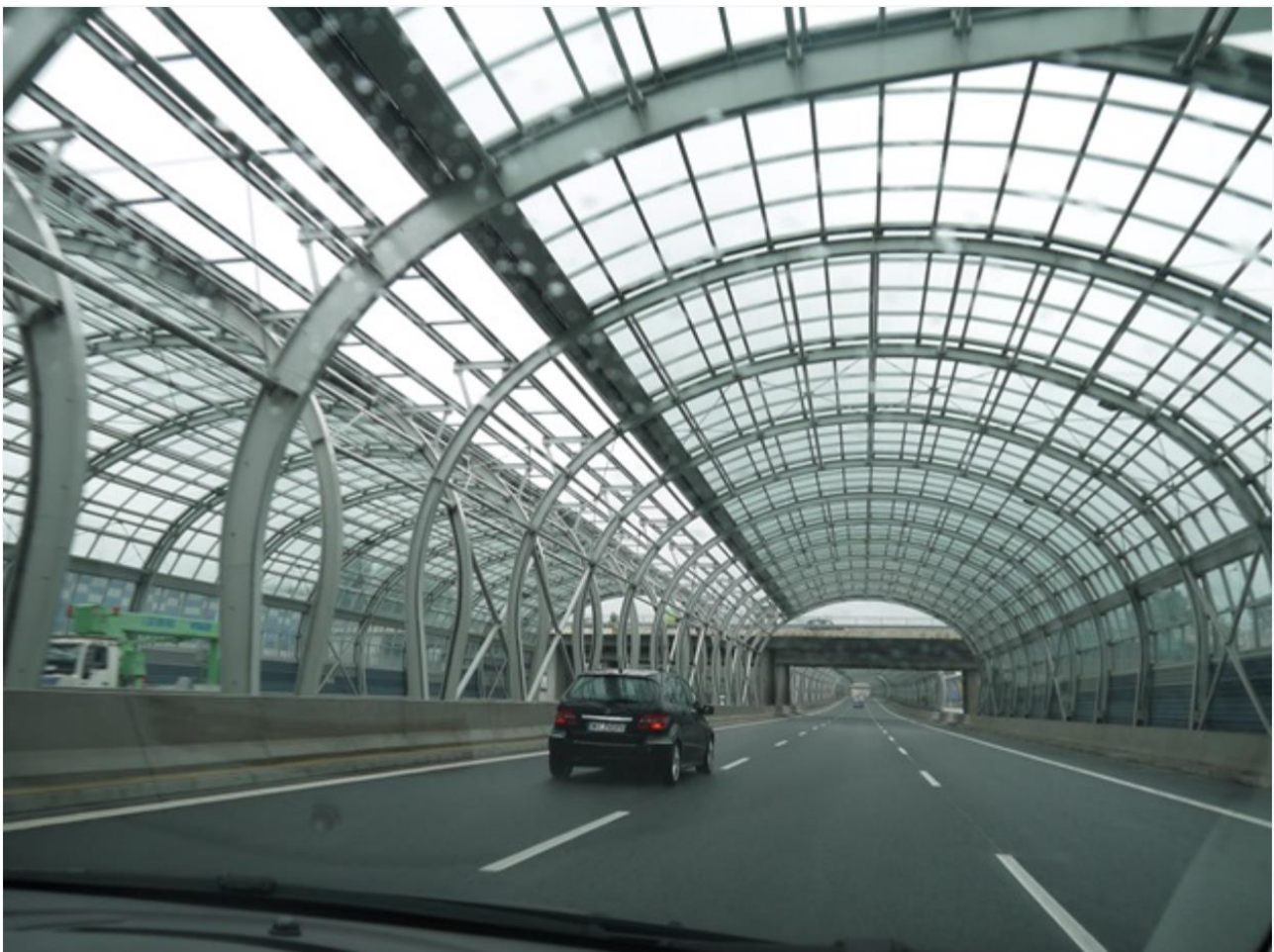
Figur 2 Transparent overdækning i Polen /1/
