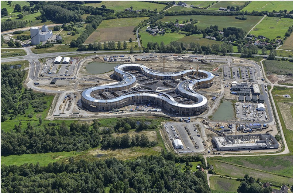
Byggeplads for Nyt Hospital Nordsjælland, juli 2023.
