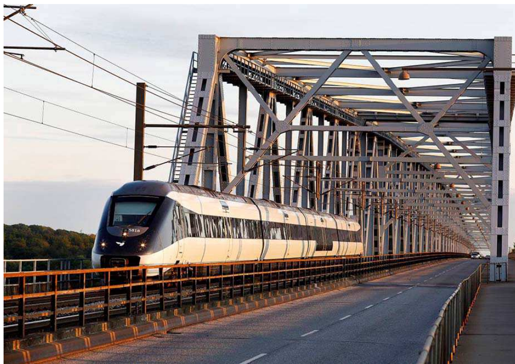
IC4-tog ved Lillebæltsbroen.
