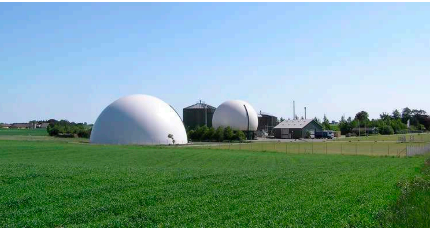
Hashøj Biogas. Produktion af biogas udnytter landbrugets og fødevarereproduktionens restprodukter. Næringsstofferne kan føres tilbage til jorden. Foto: Bruno Sander Nielsen
