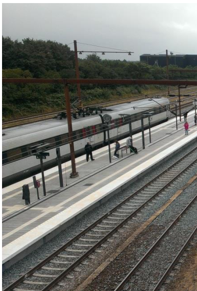
Tinglev St. har perronhøjde 55 cm
