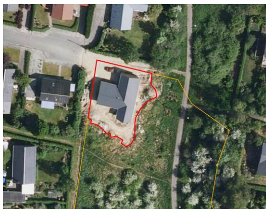
Foto 6: Nybygget hus. Digitaliseringen inkluderer det omkringliggende forstyrrede areal. DDO ® land 2008. COWI ® .
