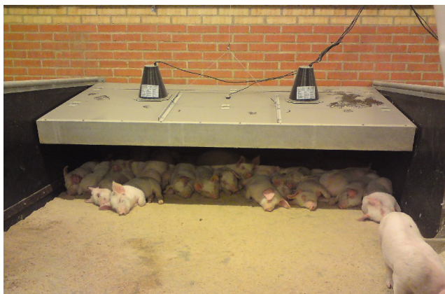
Ingen rum- eller gulvvarme, kun intelligent styrede IR lamper og overdækning = 5 kWh/stiplads/år
