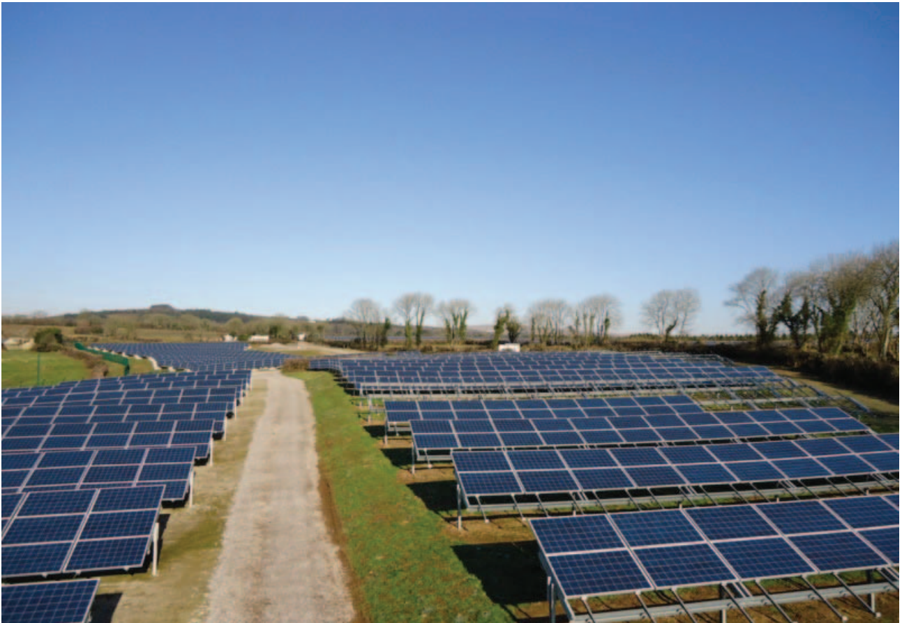
Solcellepark under opførelse
