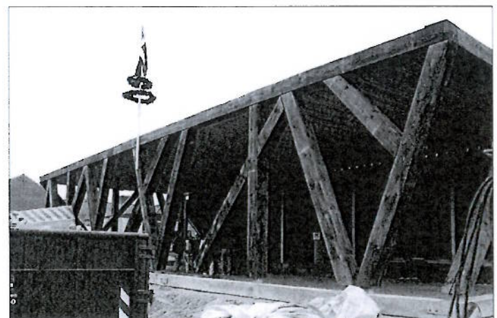
Fra rejsegildet på den nye Rebildport, hvor der er anvendt træ fra Rold Skov i en del af de bærende konstruktioner. Privatfoto
