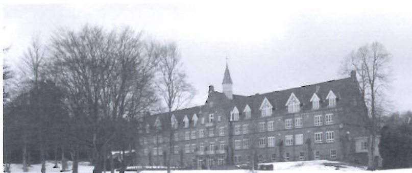
Sanatoriet i Skørping. Hovedbygningen. Morten Pedersen 2005.
