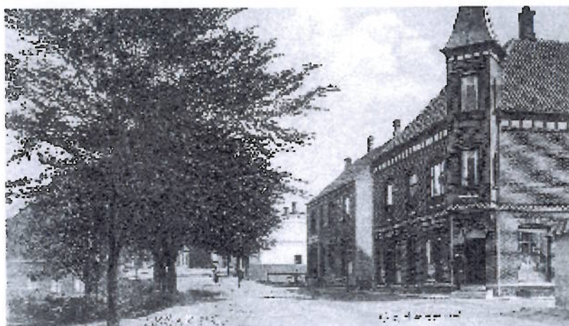
Jyllandsgade 12. Indbegrebet af stationsbyarkitektur med hjørnetårn, hjørneindgang, mæn-stermuringer og en flot skorsten. Lokalhistorisk Arkiv for Skørping Kommune.
