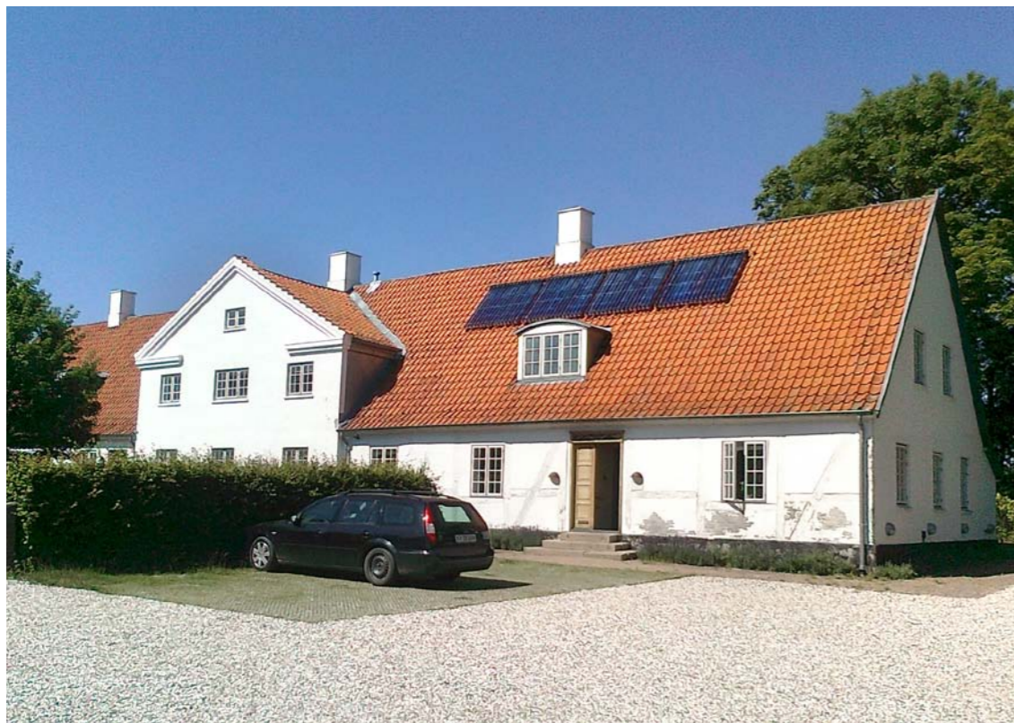
Hovedbygningen til Strandegaard ved Feddet, ud for Stevns' sydkyst, er fra 1700-tallet, og opført i bindingsværk og grundmur i typisk barokstil. Da bygningen skønt gode kvaliteter ikke er fredet, er montering af solcelleanlæg på forsiden af taget ikke ulovligt. Foto: Erica Mangaard Heyckendorff, juli 2012.
