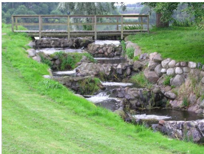
OPSTEMNING VED VANDMØLLE I NORDJYLLAND, HVOR DER ER ETABLERET FISKETRAPPEN. FISKETRAPPEN OG DEN OPSTUVEDE VANDLØBSSTRÆKNING (ØVERST I BILLETET) FORSTYRRER FAUNAENS VANDRING OG FØRINGER KONTINUITETEN I VANDLØBET.
