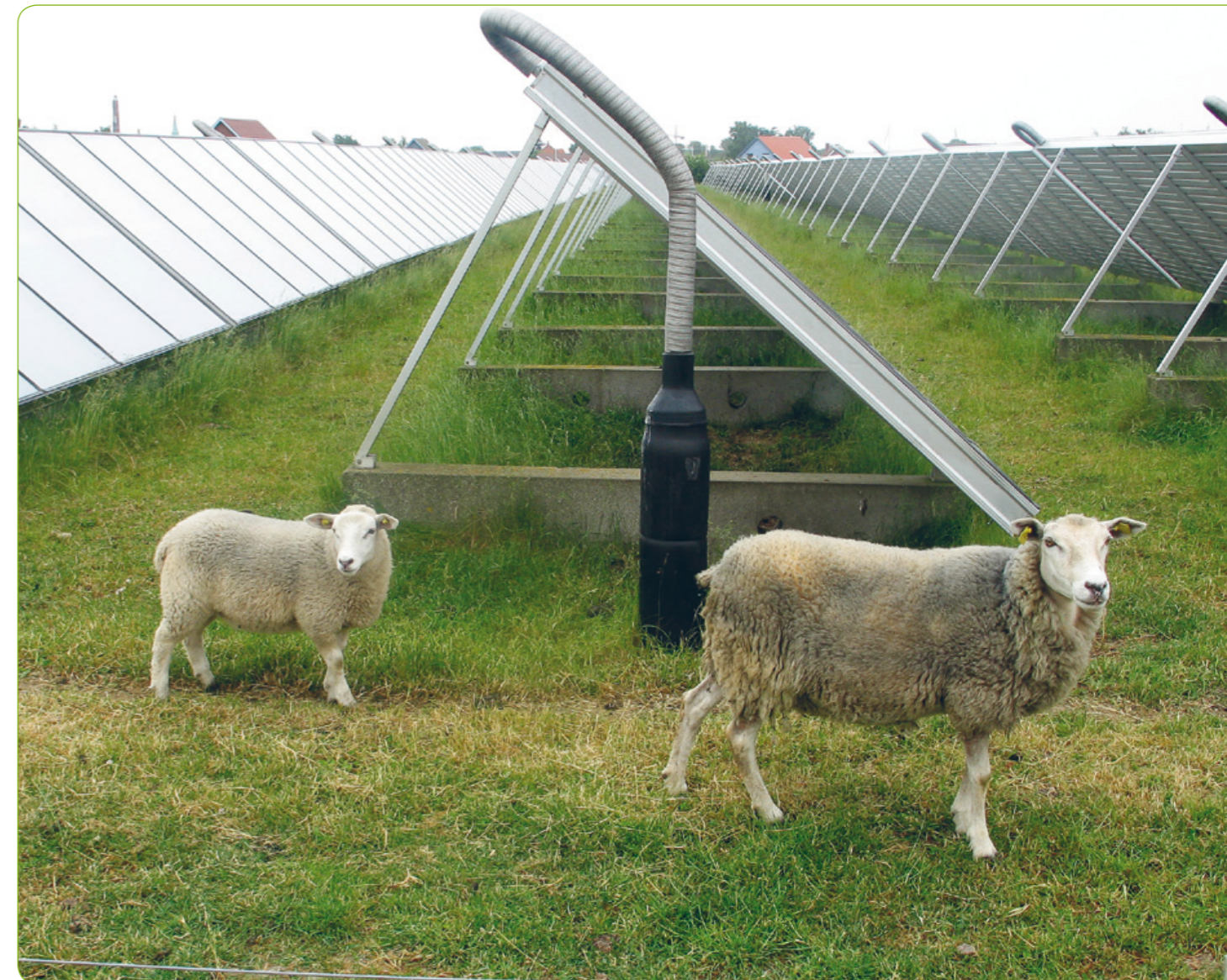
Verdens største solvarmeanlæg findes i Marstal på Ærø. Det strækker sig over godt 18.300 m 2 og dækker ca. 1/3 af byens varmebehov. Anlægget erstatter et årsforbrug på 850.000 liter olie og reducerer CO 2 -udledningen med ca. 2.300 tons på årsbasis.
