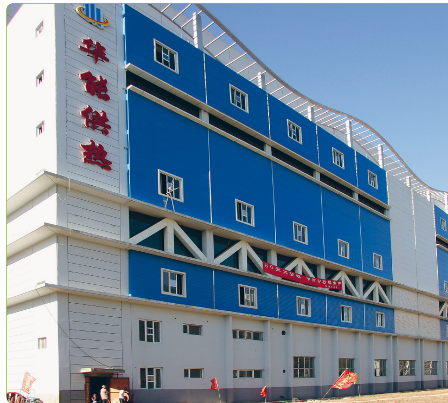
I 2007 blev det hidtil største, danske fjernvarmeprojekt i Kina indviet. På billedet ses det nye kraftvarmeværk i Harbin, der er hovedbyen i den nordøstlige provins Heilongjiang. Værket leverer fjernvarme til ca. en million af byens 9,5 mio. indbyggere. Projektet reducerer kulforbruget med ca. 300.000 tons og CO 2 -udledningen med ca. 500.000 tons om året.
