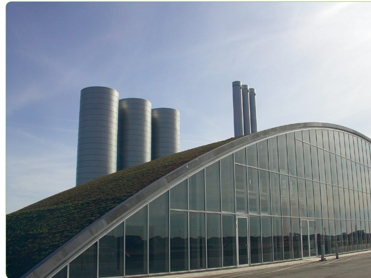
Centralkommunernes Transmissionsselskabs spidslastcentral i Københavns Lufthavn. Gottlieb Paludan har tegnet centralen, og værkets arkitektoniske stil er i fin harmoni med omgivelserne.
